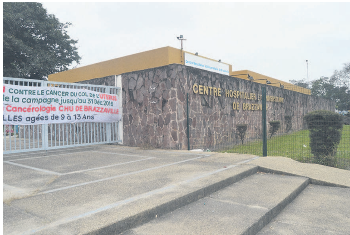
La façade principale du CHU
