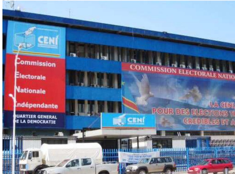
Le siège de la Céni sur le boulevard du 30 juin
