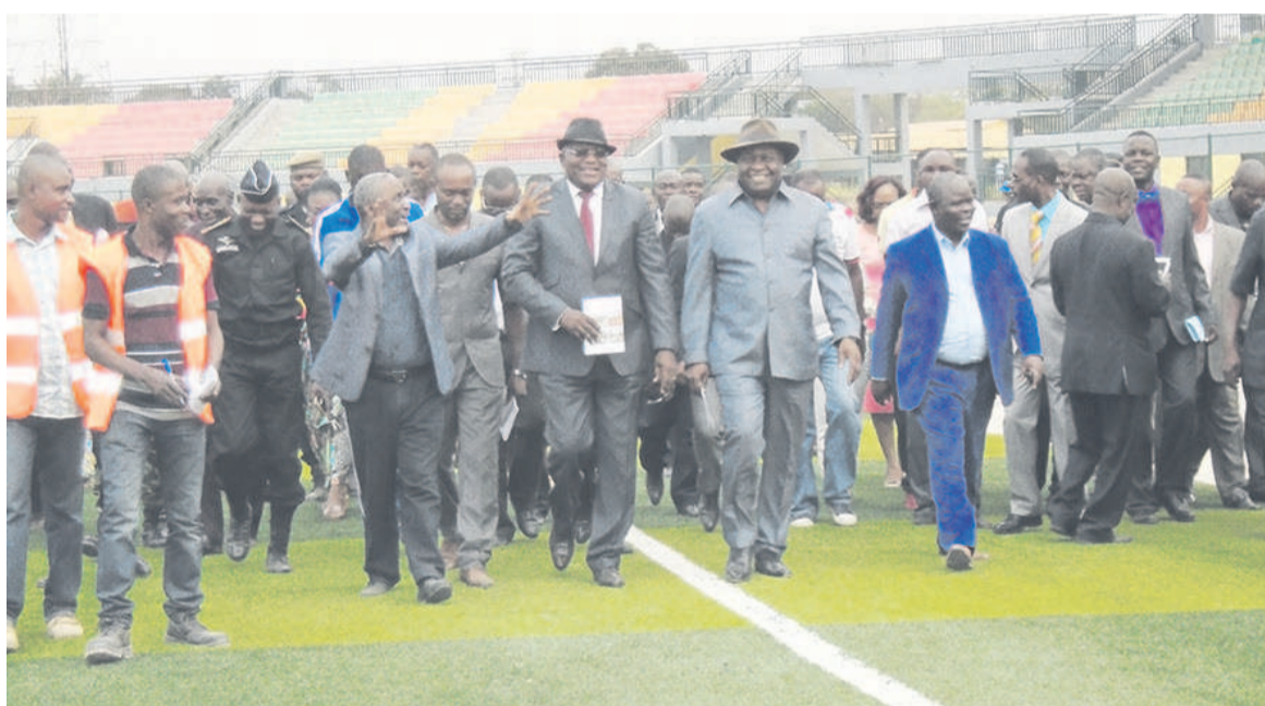
Léon Alfred Opimbat, Jean Michel Mbono et le préfet de la Bouenza visitant le chantier du stade (Adiac)
