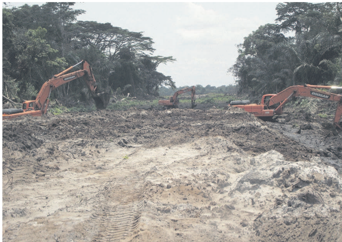
Un tronçon de la route Edou-Mpama en construction
