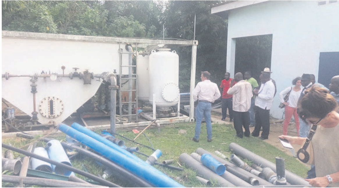
La visite des installations des techniciens de l'ADEA à Ewo/photo DR
