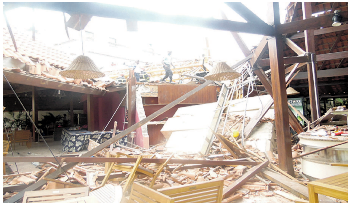
Les dégâts de l'accident Crédit photo: Adiac»
