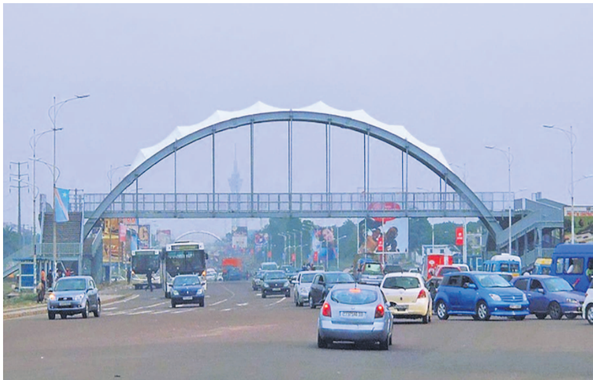
Entrée du Boulevard Lumumba à la hauteur de la 1re rue Limete
