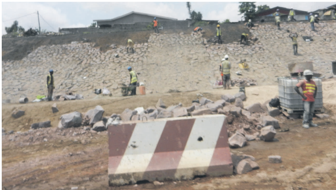
Les techniciens oeuvrant sur le chantier de la corniche (adiac)
