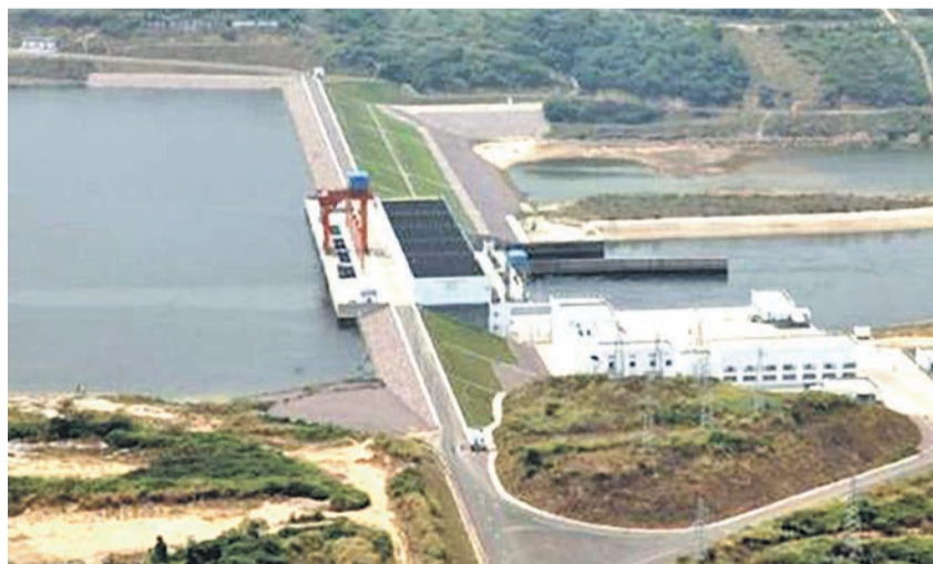
Le Barrage Hydroélectrique de Moukoulou
