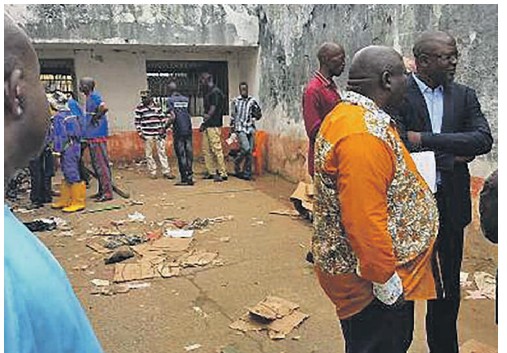
Evaluation des dégâts après l'évasion
