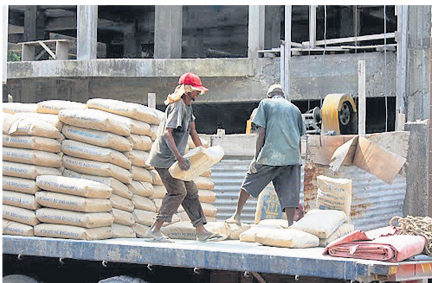
Déchargement d'une cargaison du ciment gris
