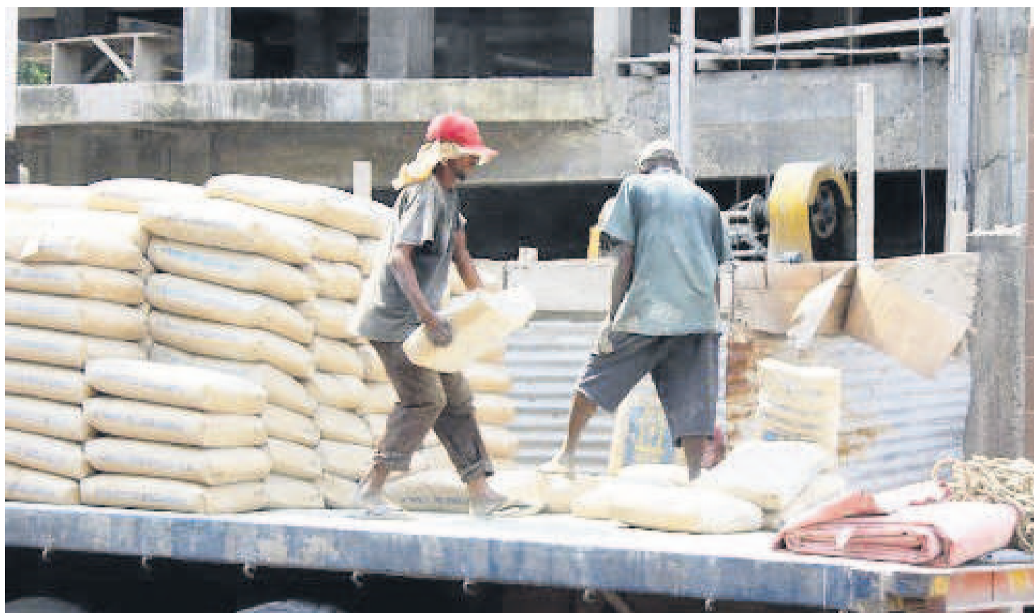
Déchargement d'une cargaison du ciment gris
