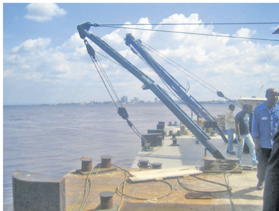
Les bâtiments destinés aux opérations de dragage
