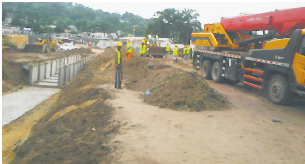
Les ouvriers de la CRBC à pied d'œuvre
