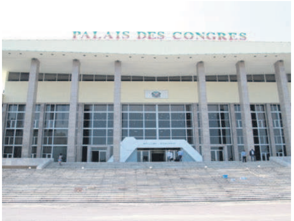
La façade principale du Palais des congrès des prochaines rencontres.
