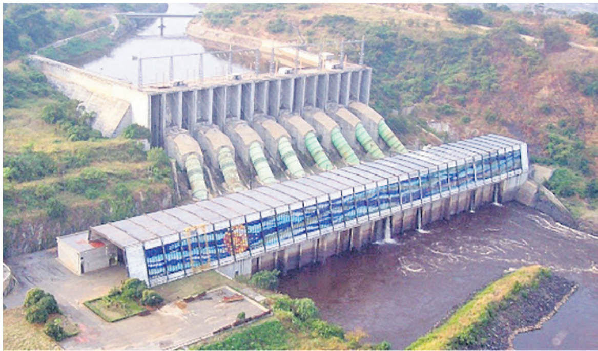
Le barrage hydroélectrique d'Inga
