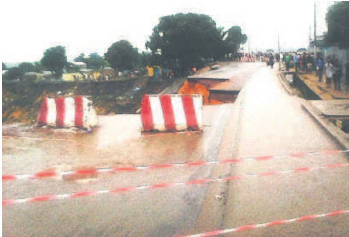
Une vue de la voie coupée par l'érosion (Adiac)
