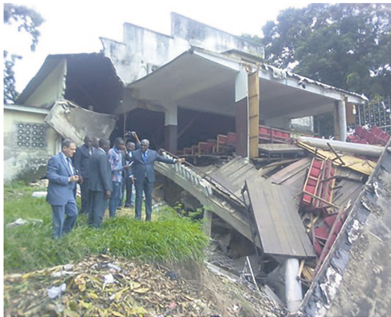
Une vue de l'arrière du bâtiment (Adiac)
