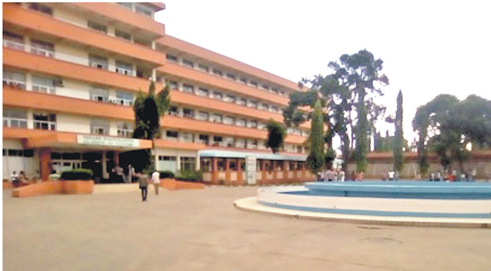
Une vue de l'hôpital général de Loandjili / crédit photo Adiac
