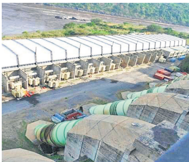
Barrage hydroélectrique Inga II
