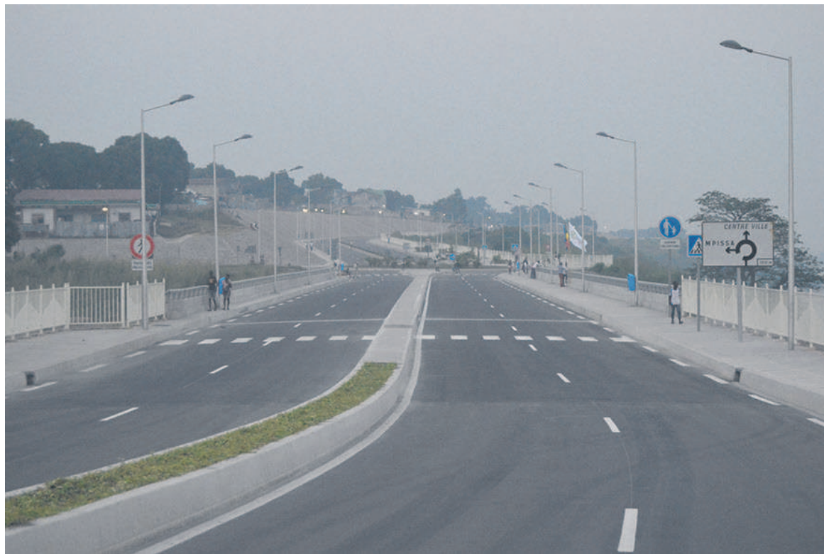
Un tronçon de la route (Adiac)
