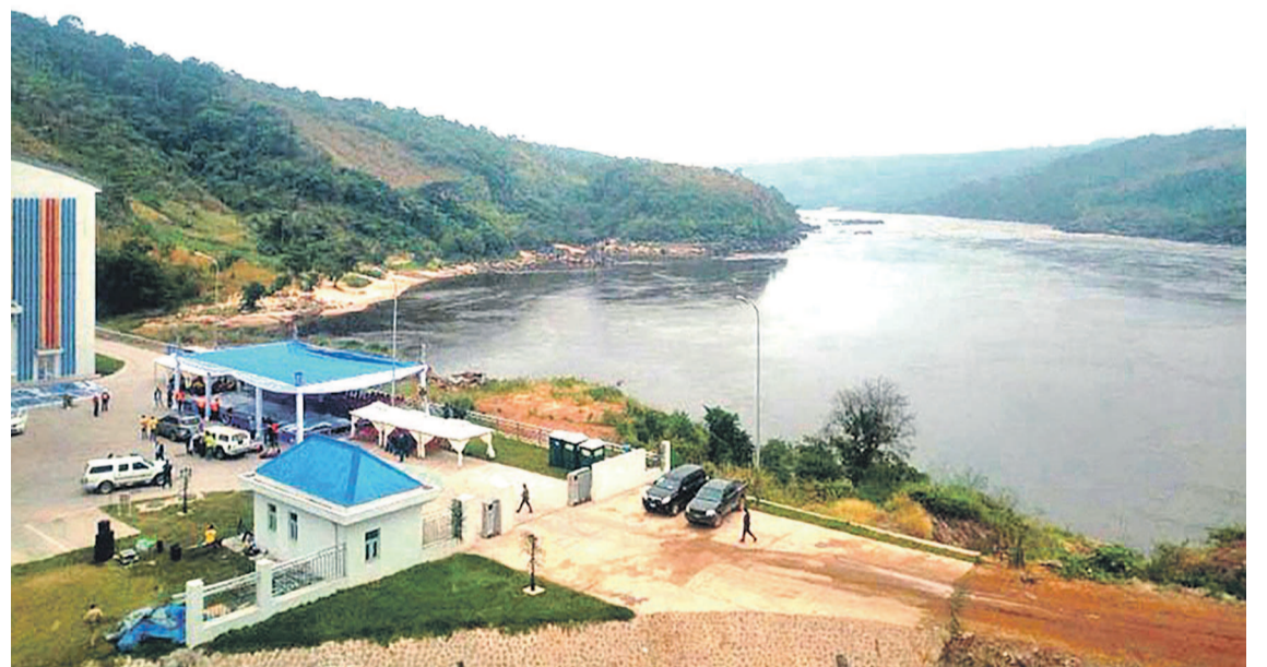
La centrale hydro-électrique Zongo II
