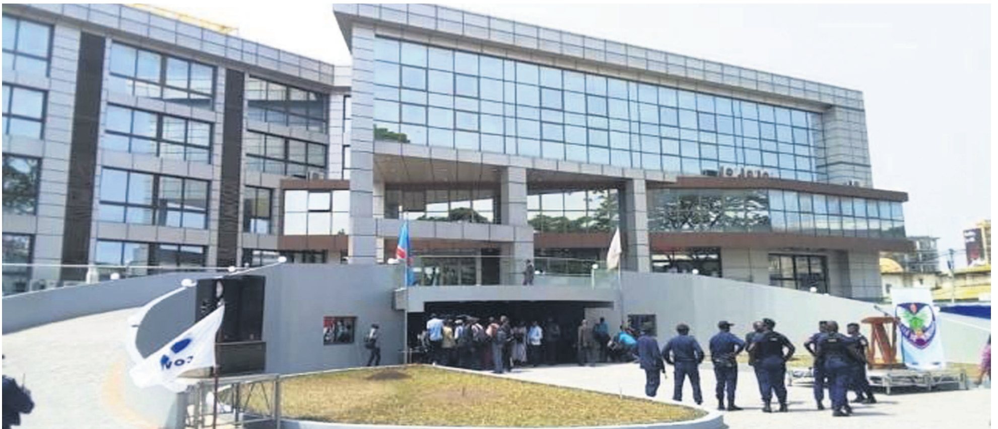
Le nouveau bâtiment abritant les services du gouvernement de la ville
