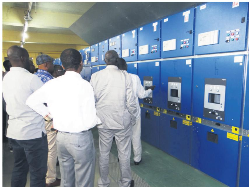
Une vue partielle des cellules PIX installées par le PEEDU au poste-source Tsielampo
