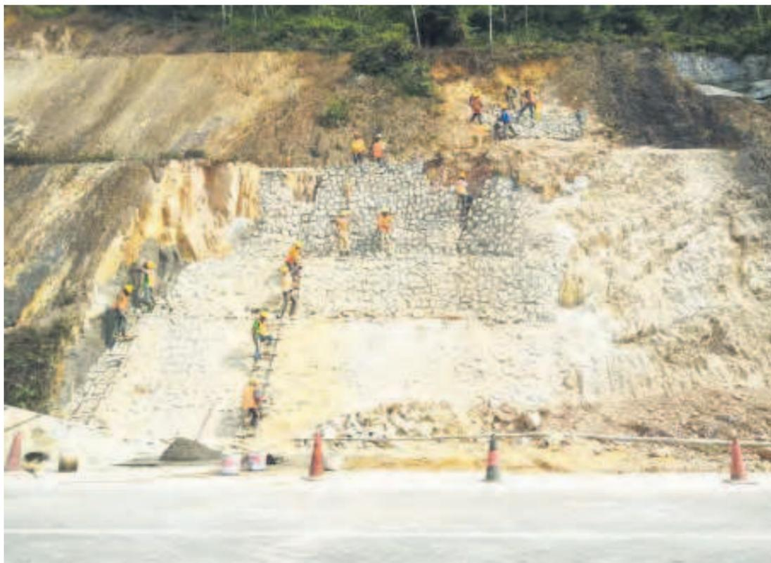
Les travaux du perré maçonné pour réparer le talus tombé
