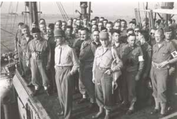
Débarquement de Provence à partir du 15 août 1944
