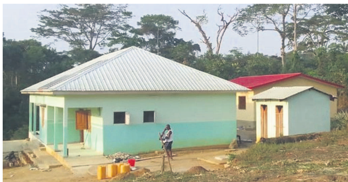
Les locaux du CSI, du personnel soignant et les sanitaires externes/DR
