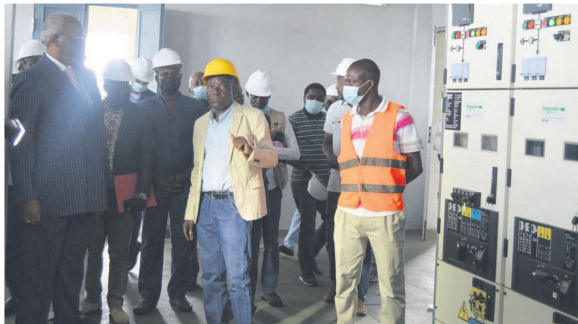
Hugues Ngouélondélé visitant la centrale électrique Adiac
