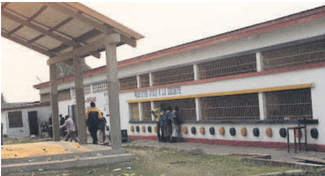
Une vue intérieure de l'ex prison central de Makala
