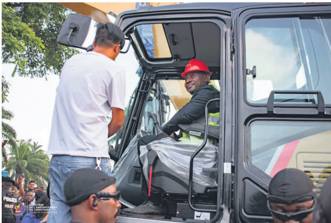
Guy Loando donnant le coup d'envoi des travaux de modernisation de la voirie à Mbandaka
