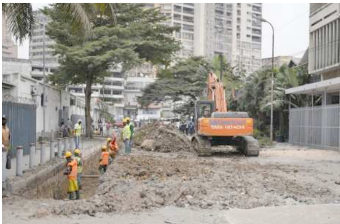
Les travaux sur l'avenue de la nation
