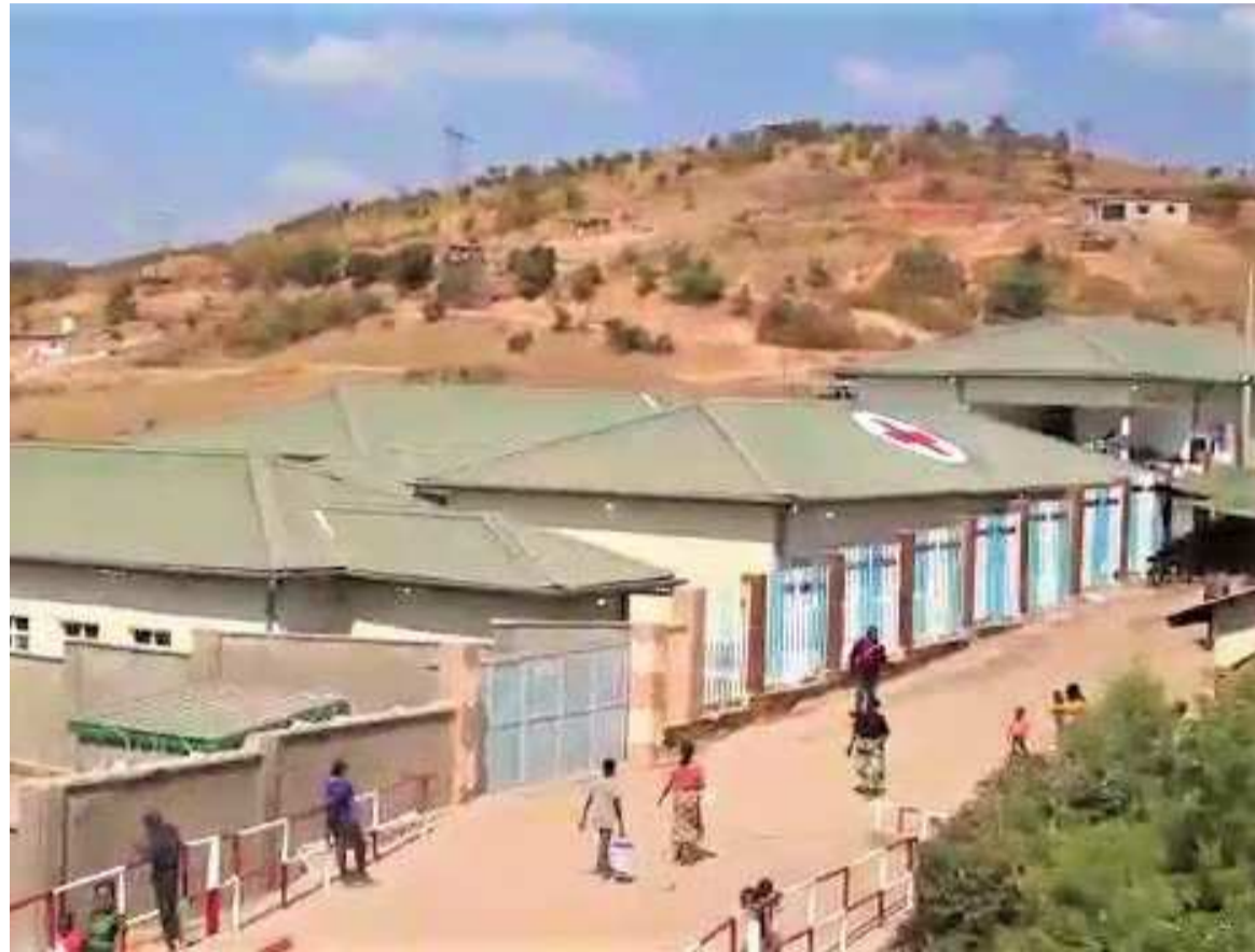
Une façade du centre de santé rénové./DR
