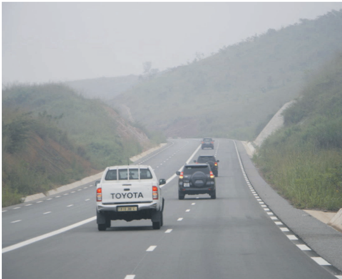
Une route bitumée Photo Adiac
