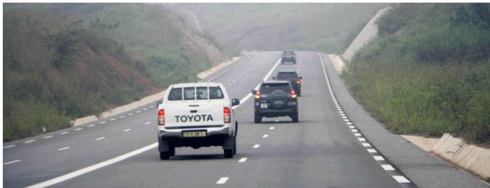
Une route bitumée/Photo Adiac
