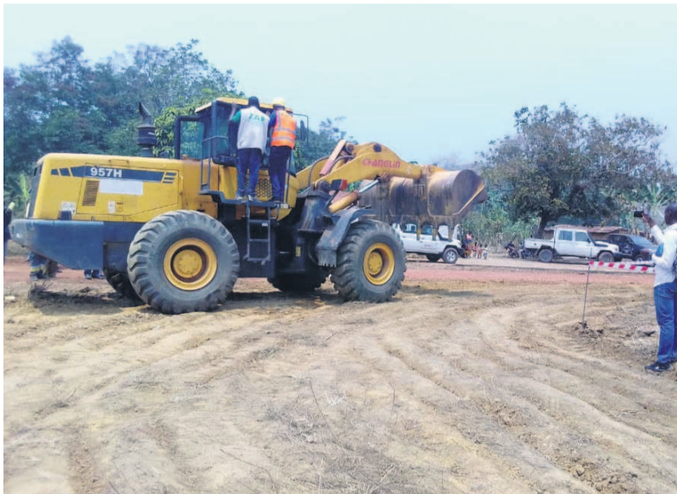
Le directeur de cabinet du ministre de l'Agriculture lançant les travaux de réhabilitation de la piste Adiac
