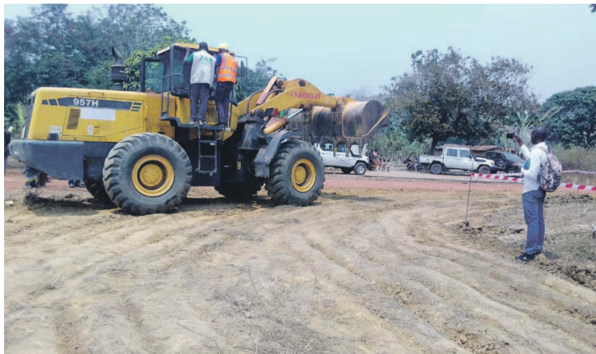
Le directeur de cabinet lançant les travaux de réhabilitation de la piste Adiac
