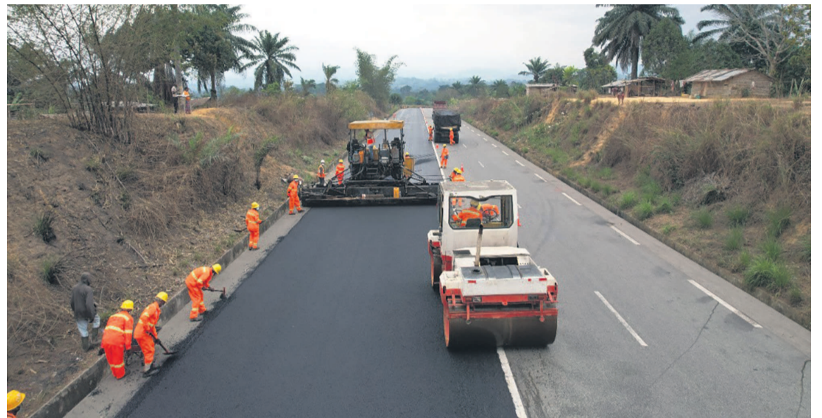
Les travaux à l'entrée du Mayombe/Adiac
