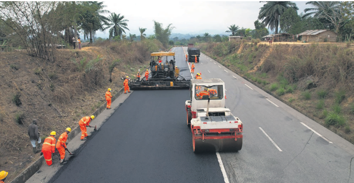
Les travaux à l'entrée du MayombeAdiac
