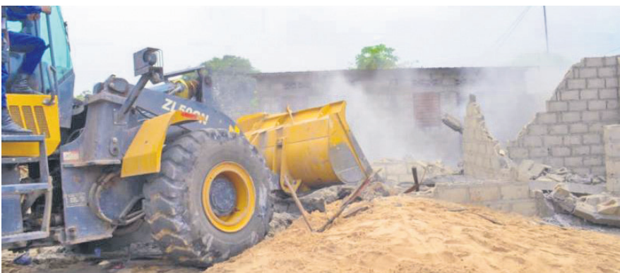
Démolition des constructions anarchiques à Limete
