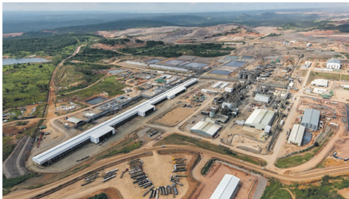
Usine de traitement de cuivre et cobalt de Tenke Fugurume/DR
