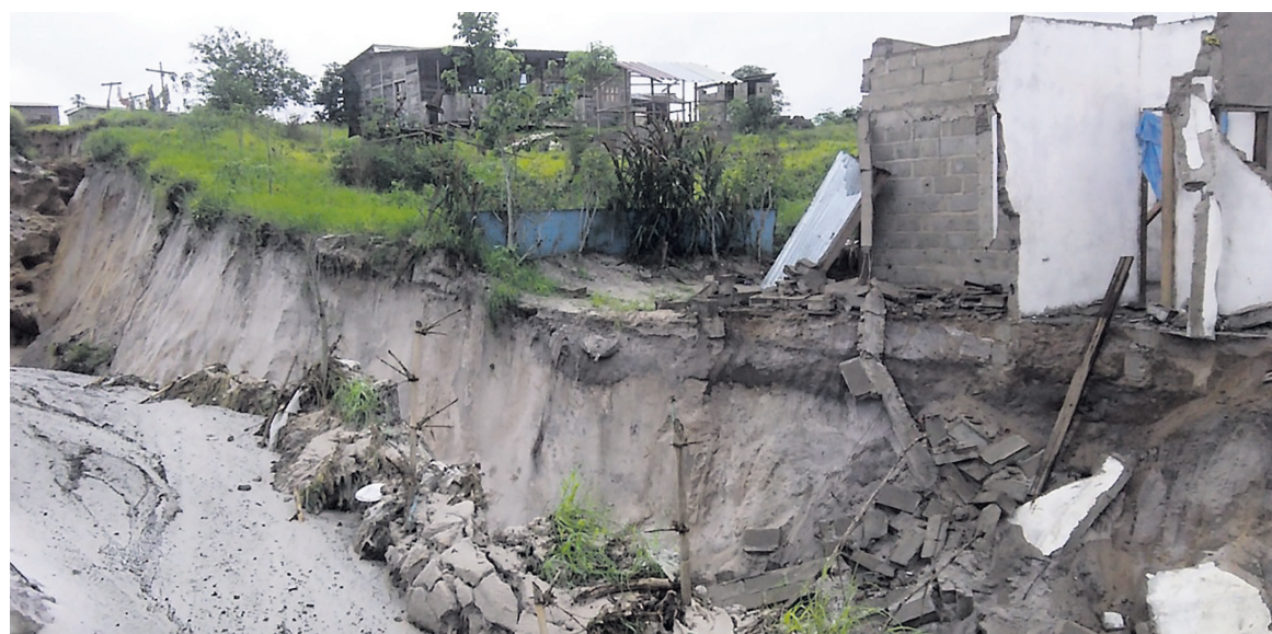
Des habitations s'écroulant une à une à cause de la digue mal érigée en amont./Adiac
