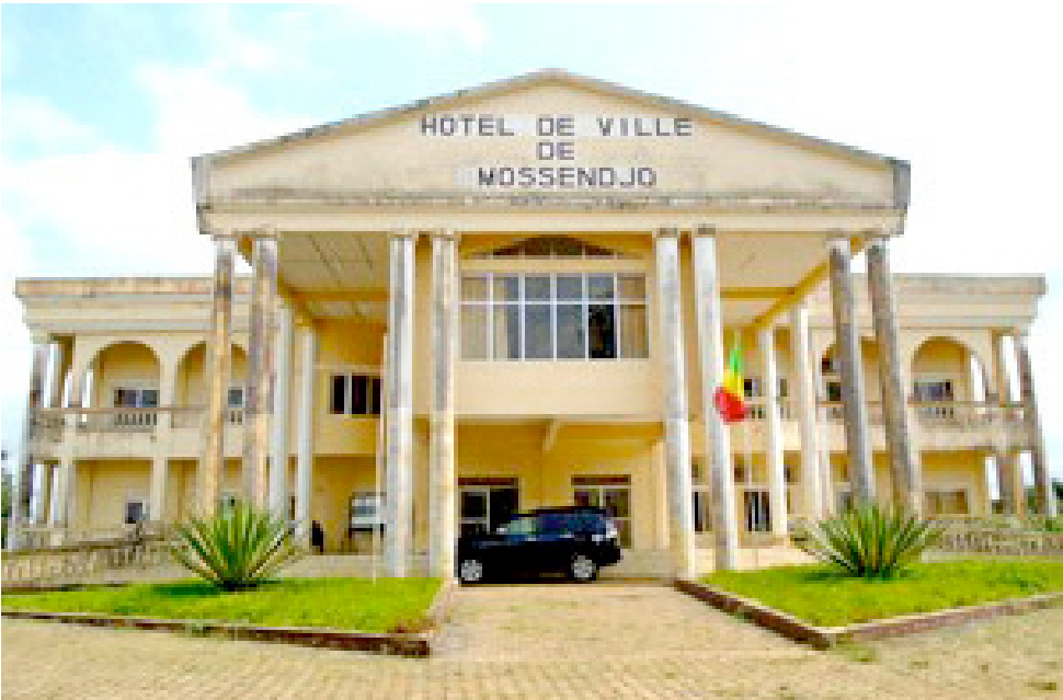
La façade principale de la mairie de MossendjoDR
