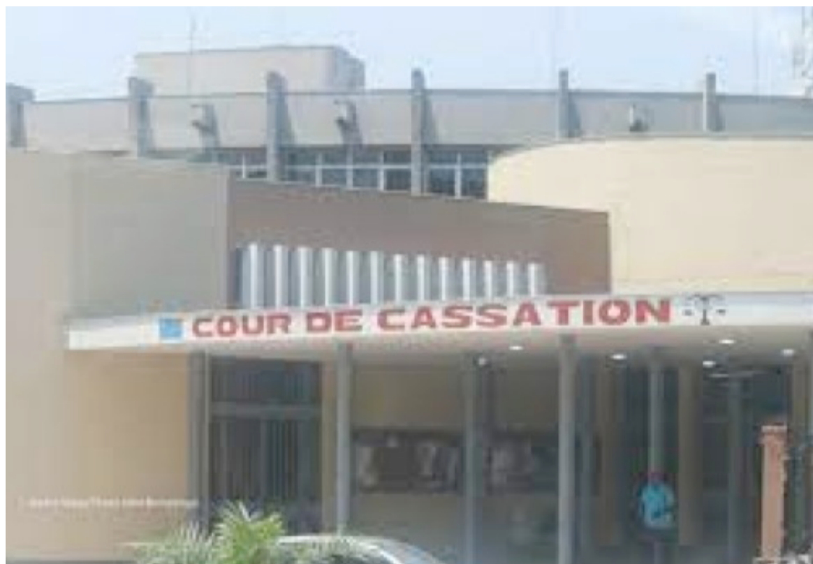
Le bâtiment de la Cour de cassation/DR
