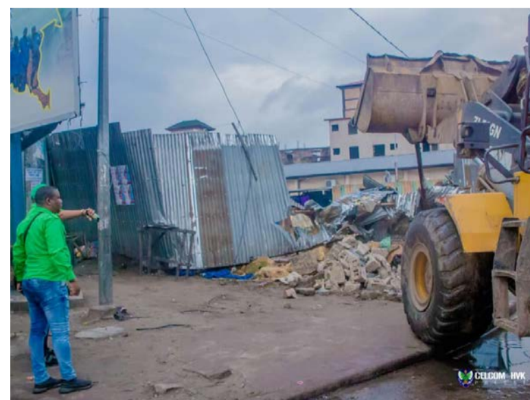
Des bulldozers de l'Hôtel de ville à Kintambo magasin
