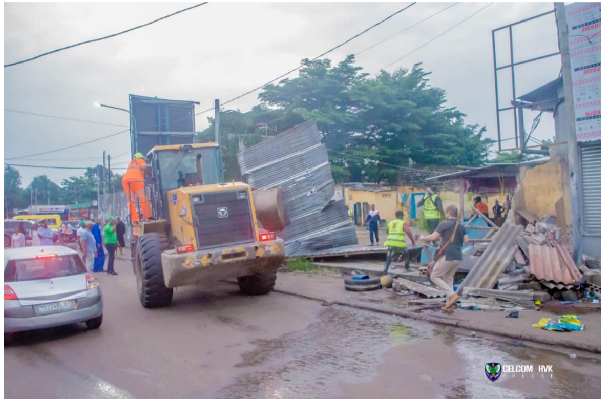
Des bulldozers de l'Hôtel de ville à Kintambo magasin
