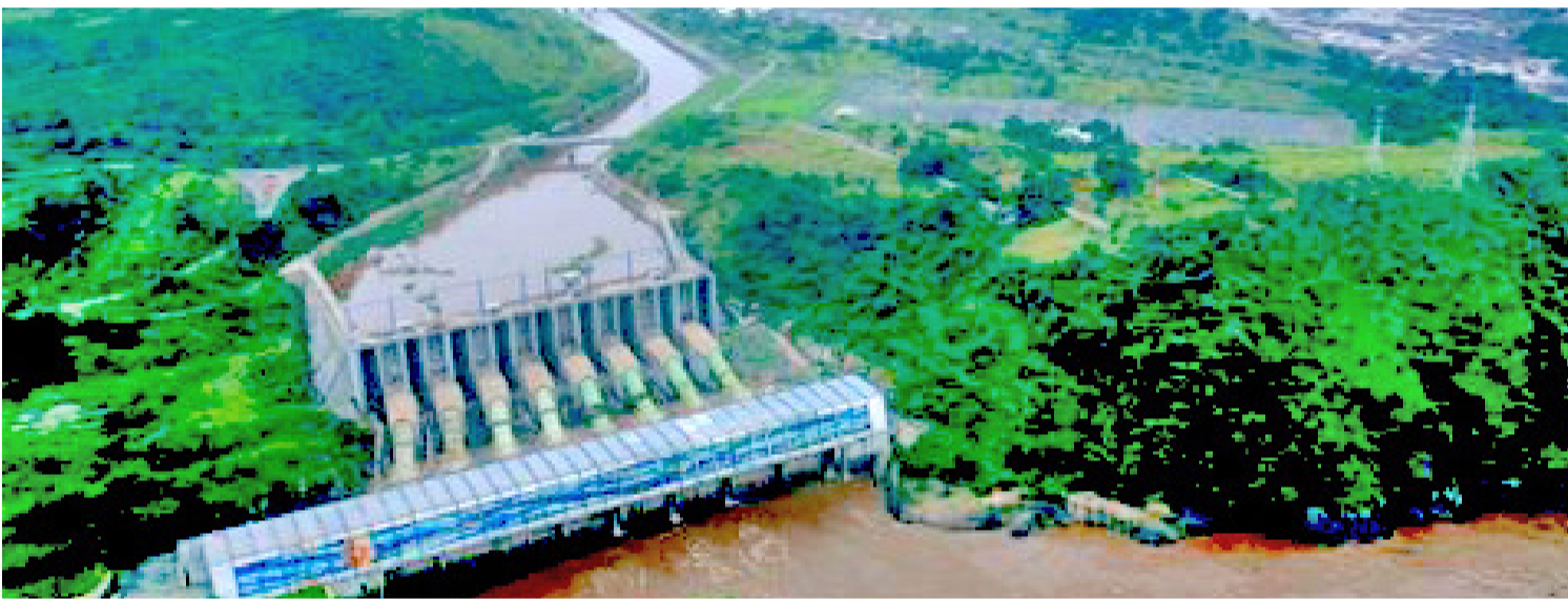
La Centrale hydroélectrique d'Inga
