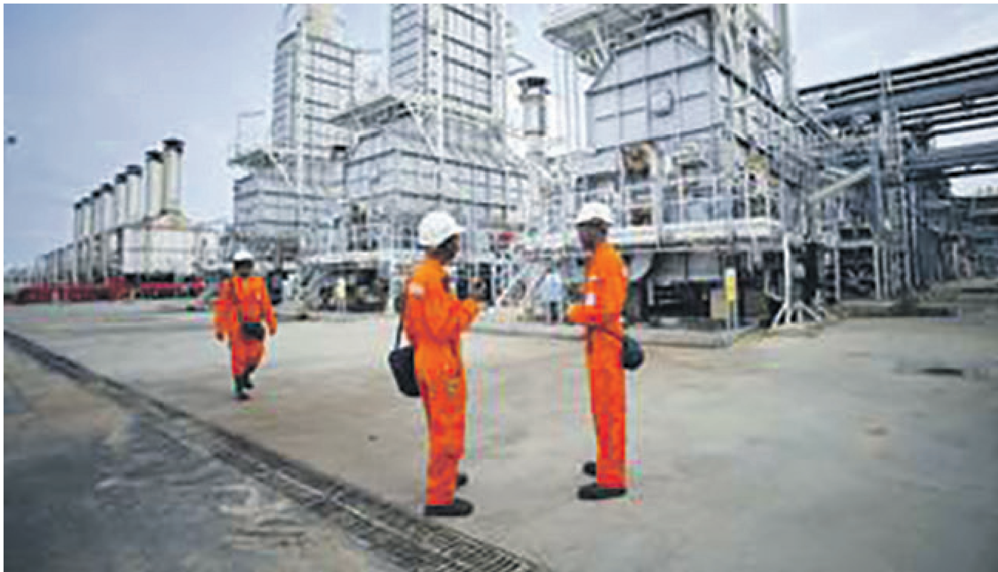
Les installations de la SNPCOR
