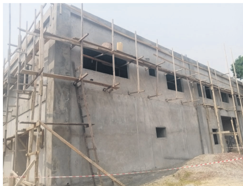
Le chantier de rénovation du Cercle culturel de Poto-Poto/Adiac
